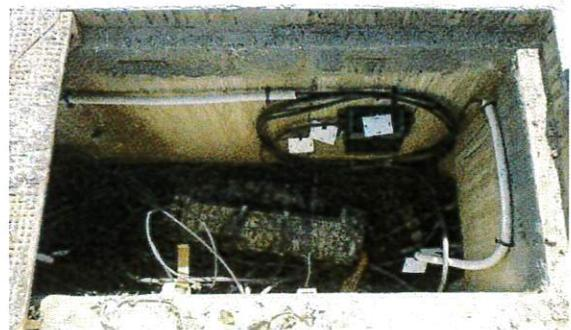
**Attention aux manipulations de ces câbles, la fibre optique doit être manipulée avec précaution et casse si elle est pliée**
